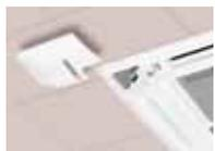
Пользуясь специальными окошками под угловыми крышками, внутренний блок можно выровнять, не снимая панель. Время монтажа уменьшается, сам монтаж упрощается.
